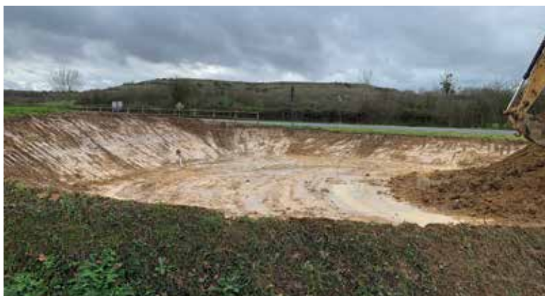
Les travaux engagés rue de la Promenade et rue des Gravelles vont permettre de recueillir les eaux pluviales et de parer aux inondations
