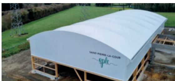
Extension du Gymnase avec un terrain de tennis extérieur et un terrain en intérieur
