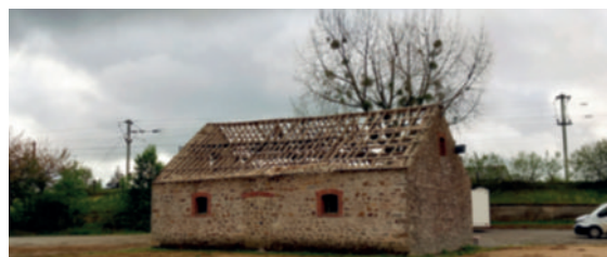
Boulodrome : les travaux viennent de commencer et devraient s'achever en octobre 2023.
